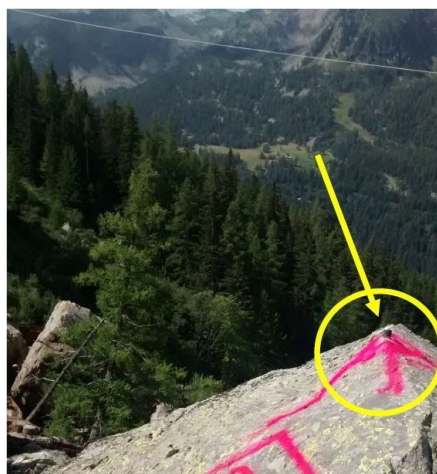
Exemple de borne GNSS installée sur le glissement de terrain de Bosmatto
