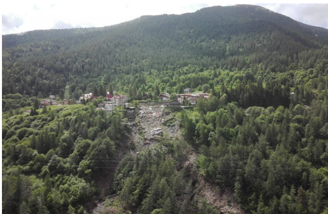
Vue du front du glissement de terrain de Monesi (Photo Notti D., CNR-IRPI siège de Turin)
